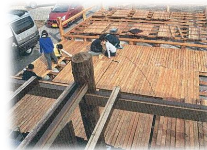
「夢たびとBASE」の手作りウッドデッキ
